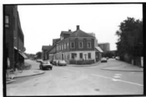
Hus 1 från NV
