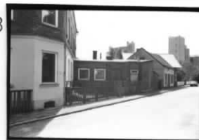
Hus 2 från NV
