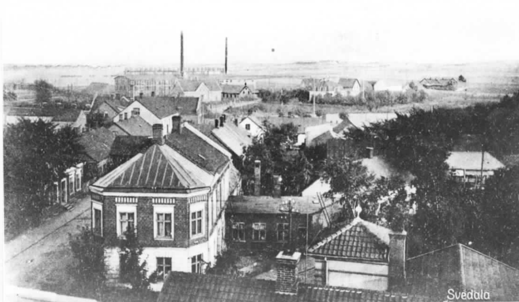
Stg 316 sett från väster. Bilden är tagen före 1948.
